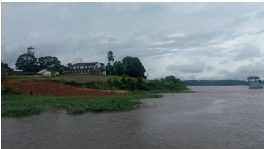
FIGURA 2: A caixa d'água instalada pela Ford resiste ao tempo em Fordlândia e é a primeira insinuação da cidade em meio às árvores da Floresta do Tapajós quando dela nos aproximamos de barco.
